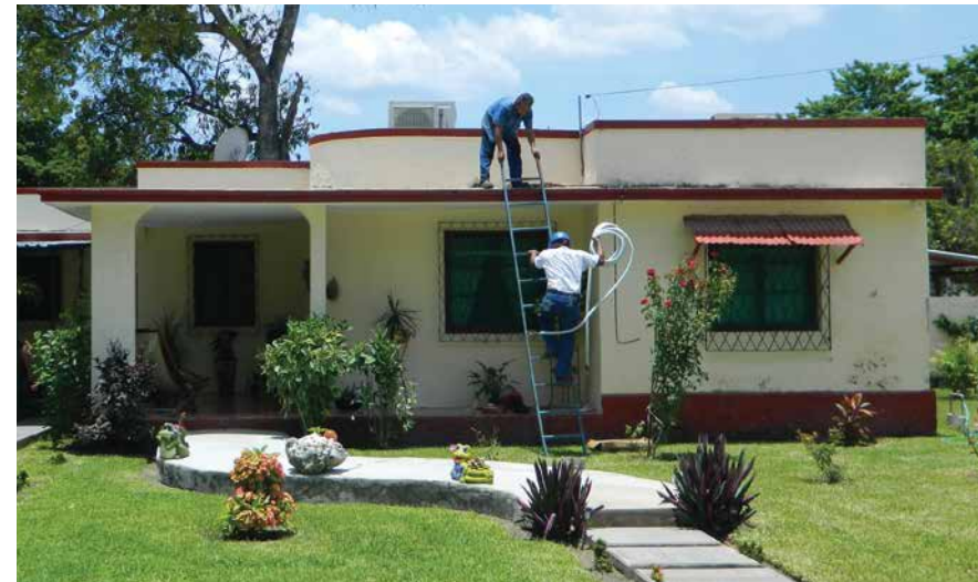
SOMOS COMPROMISO: Continuamos trabajando arduamente en la remodelación de las casas en el Ingenio La Joya. Ahora nuestros trabajadores cuentan con viviendas más dignas.
